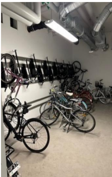
Figur 7-17 Exempel på hängande cykelställ som inte används och leder till "felparkerade" cyklar i Kraftcentralen 1.
